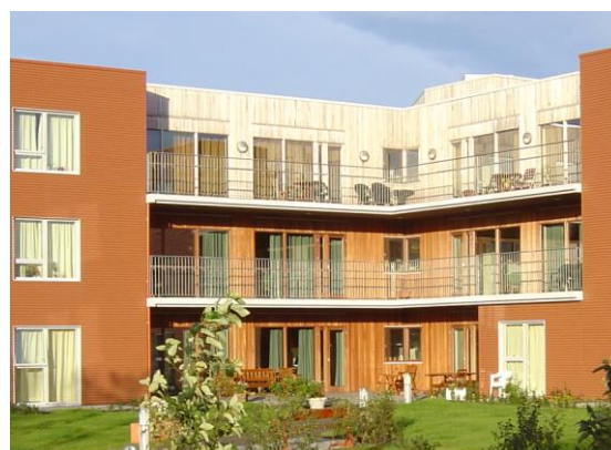
Mynd 3 sýnir utanhússklæðningu sem er í skjóli fyrir veðrun annars vegar og ekki í skjóli hins vegar og þar má sjá hvernig silfurgrái liturinn kemur fram við veðrunina.
